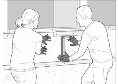
Установите теплоизоляцию в шахматном порядке между горизонтальными брусками.
